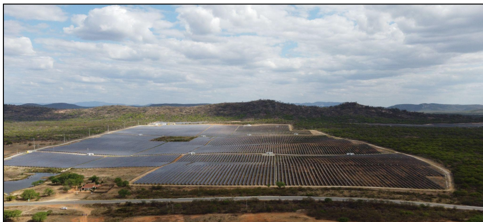
REGISTRO FOTOGRÁFICO 04 - VISÃO PANORÂMICA DA USINAS FOTOVOLTAICAS EM MALTA (OUT 2022)
