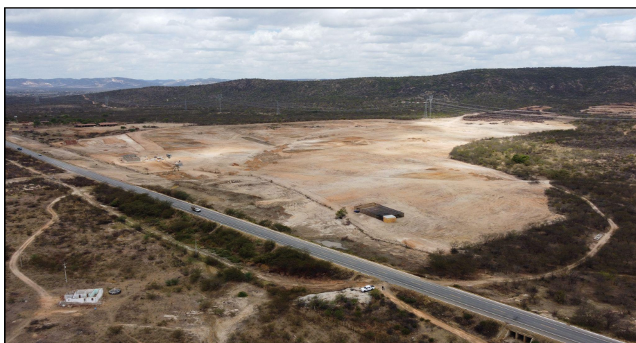
REGISTRO FOTOGRÁFICO 03 - VISÃO PANORÂMICA DA USINA FOTOVOLTAICA EM CONSTRUÇÃO (OUT 2022)
